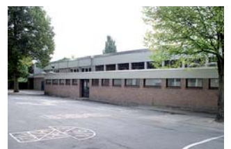
Grundschulhalle (Halle 4) Schulzentrum Alverskirchener Straße 14 48351 Everswinkel
